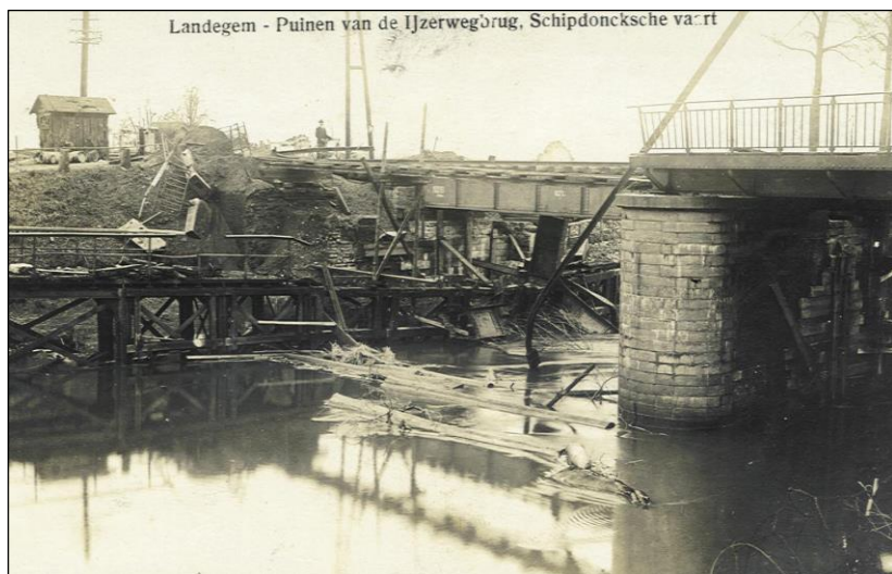
De vernielde spoorwegbrug in Landegem.
