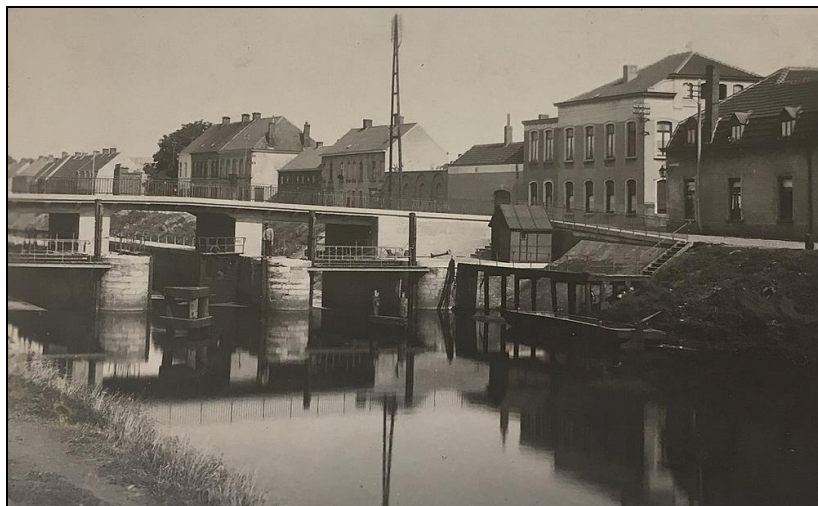
Het sas en de Schipdonkbrug in Deinze in de jaren 1950.
