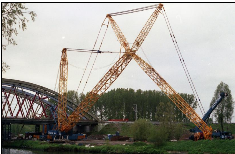
In het verlengde weekend van 1 mei 1998 werd een 86 meter lange spoorwegbrug over het Schipdonkkanaal in Landegem gemonteerd. Er werd daarvoor aan vakwerkkraan opgebouwd van 800 ton.
