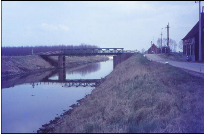
De baileybrug tussen Meigem en Bachte in de volksmond Bachtebrug genoemd omstreeks 1970. Het was een brug aangelegd door het leger bestaande uit standaardsegmenten zodat die snel kon opgebouwd worden. Rechts het cafeetje van Zulma Van de Voorde die in 1972 werd vermoord. De misdaad werd nooit opgehelderd.
