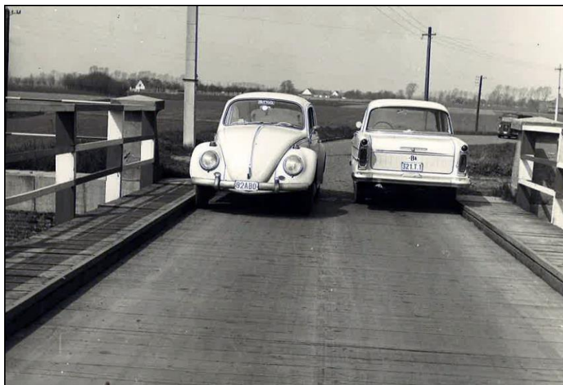
Op de smalle noodbrug over het kanaal in Landegem konden de auto's elkaar nauwelijks passeren.
