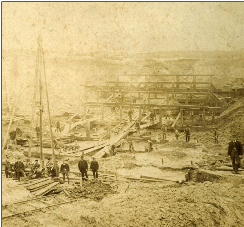
8 december 1887: het plaatsen van een tweede sifon te Schipdonk onder het kanaal van Gent naar Oostende, uitgevoerd door de Entreprise Lacroix et Bertaux onder de leiding van hoofdingenieur en directeur De Heem, ingenieur Bauwens en werfleider Jonckheere.
