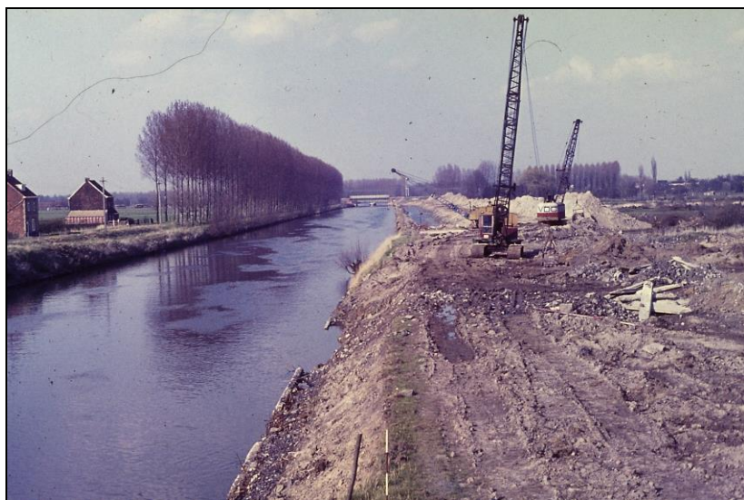
Werken aan de verbreding van het kanaal in Landegem
