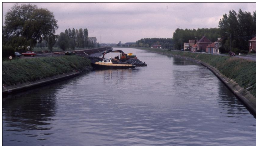
Baggerwerken bij de verbreding van het kanaal in Nevele begin de jaren 1980.
